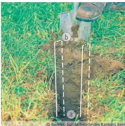
À l'aide d'une bêche de drainage, creusez une tranchée de 45 centimètres de large.
